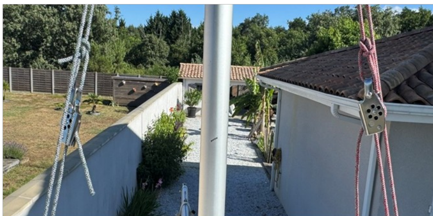
Figure 4 : passage des haubans sur la tête de la chèvre
